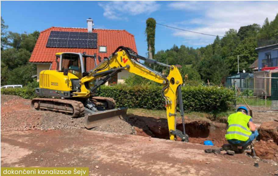
dokončení kanalizace Šejv
